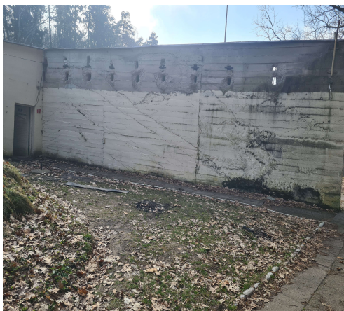
ściana do pomalowania 100m 2
