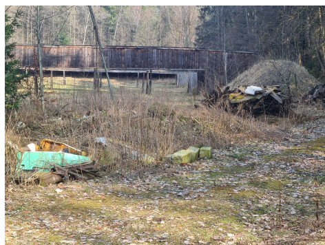
rozbiórka do wywiezienia
